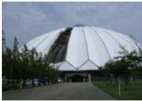
出雲ドームの被害(西村撮影)
