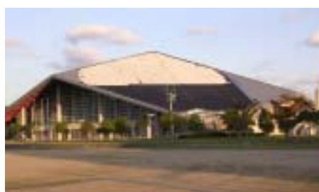
大川体育館の被害（西村撮影）
