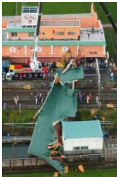
新幹線の架線に掛かったホテルの屋根 （読売新聞社提供）
